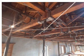
富岡倉庫1号倉庫
