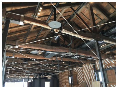
富岡3号倉庫の耐震補強用ブレース
