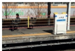
昇降式ホーム柵(JR六甲道駅)
