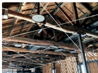
富岡3号倉庫の耐震補強ブレース
