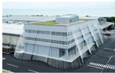
小松マテーレ(株) 自社ビル の耐震補強
