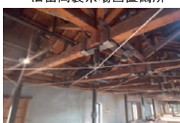
富岡倉庫1号倉庫
