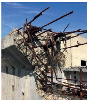
塩害等による鉄筋の腐食
